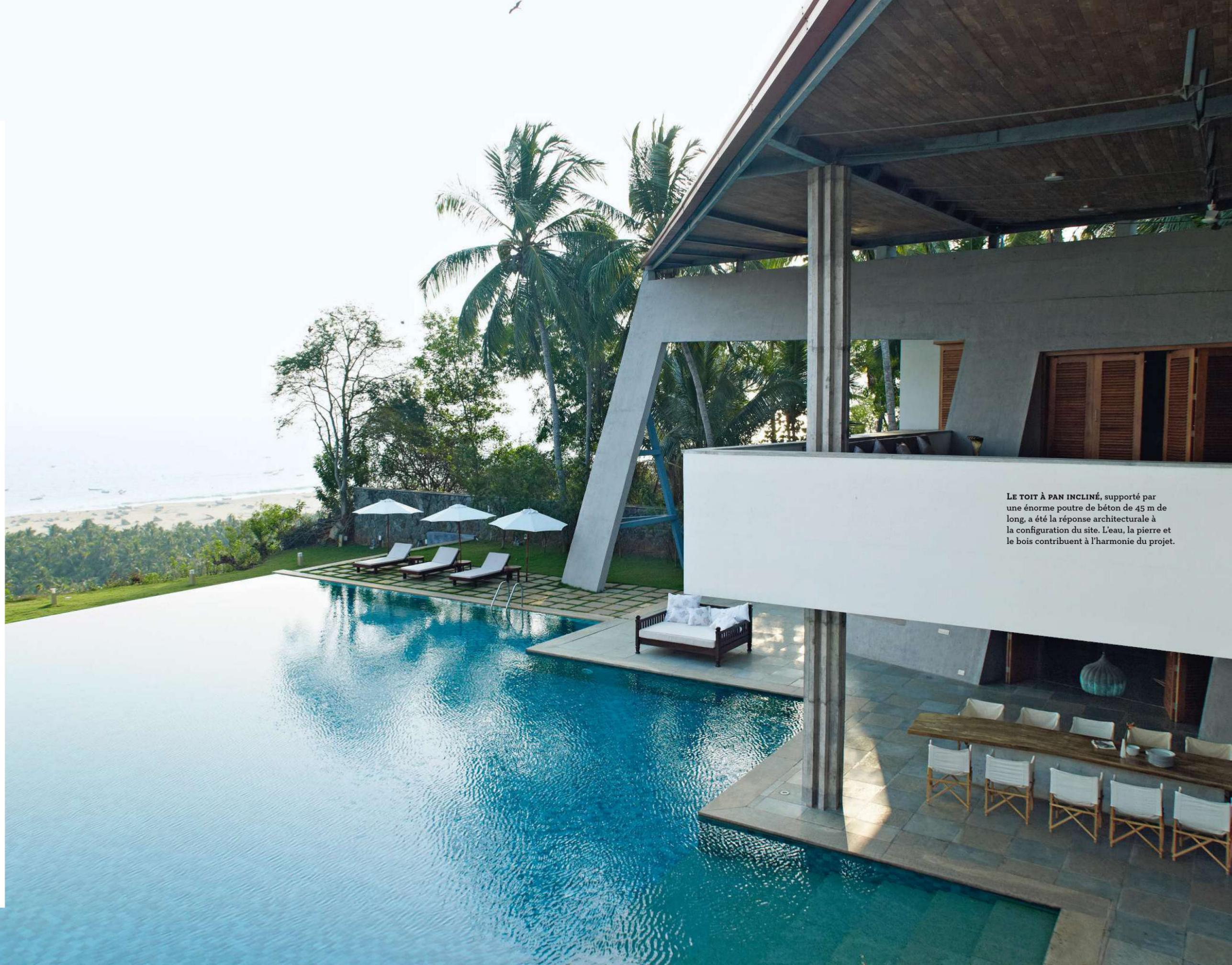
LE TOIT À PAN INCLINÉ, supporté par une énorme poutre de béton de 45 m de long, a été la réponse architecturale à la configuration du site. L'eau, la pierre et le bois contribuent à l'harmonie du projet.
